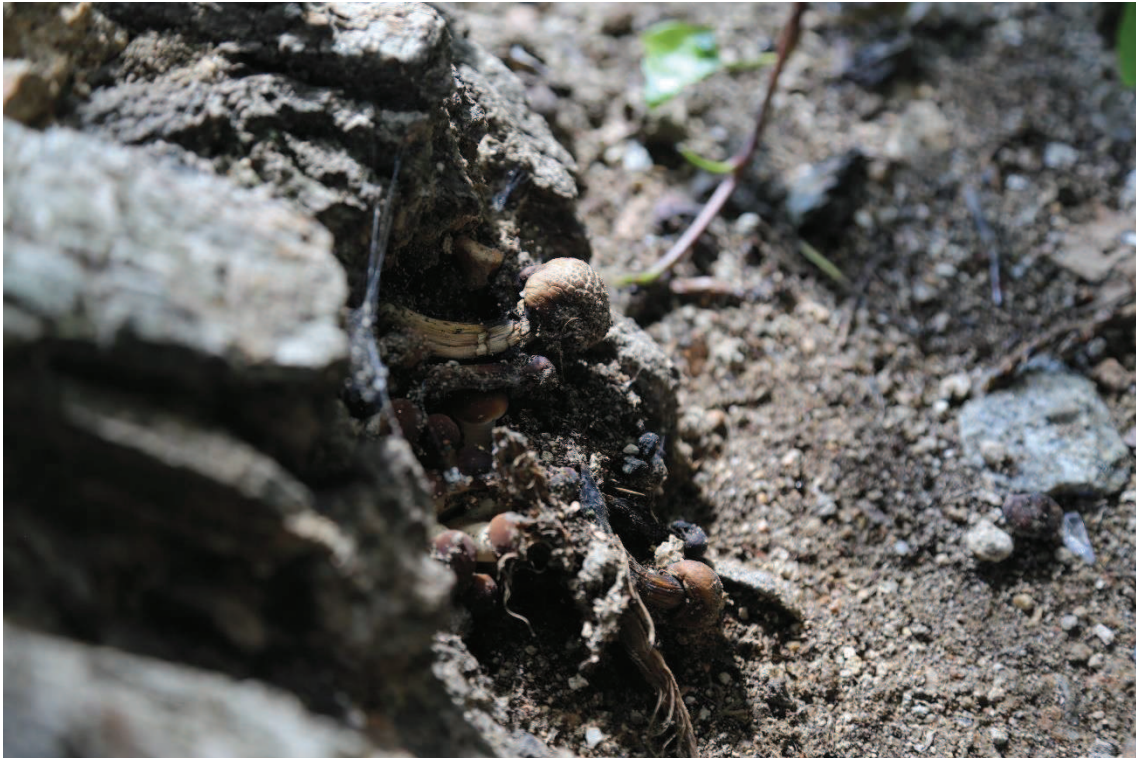
Hongos de pudrición en la base de chopo
